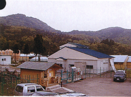
職員は手前の建物（グレーの屋根）で履き物を履き替えてから奥の管理棟（青い屋根）に向かう。農場入口はここだけ
